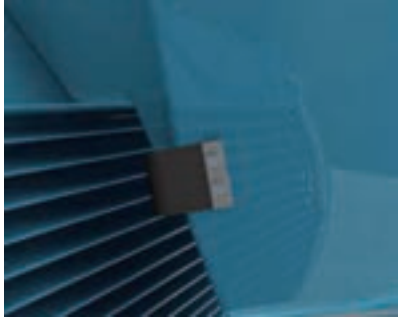
防爆型和API 541型电机使用的接地条
